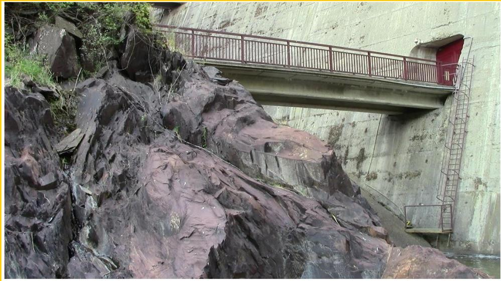
Imagen 17. Aspecto de la roca, en el tramo inicial de la Tubería, lavada por el desagüe de fondo. Tipo II de aspecto masivo al tratarse de un nivel desorganizado-replegado (*slump*).
