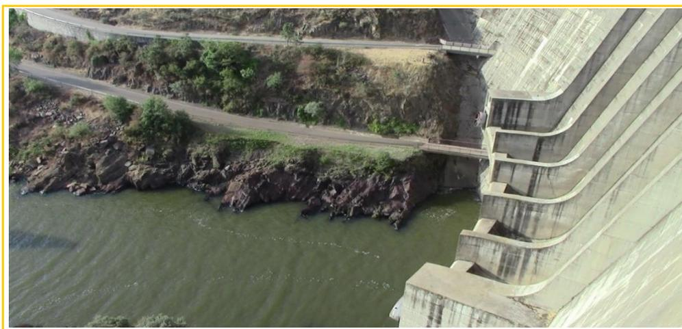
Imagen 16. Detalle del tramo inicial del trazado de la Tubería Forzada, sobre roca de Tipo II en una serie monoclinical invertida, buzamiento a la izquierda y techo a la derecha.
